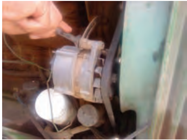
شکل ۳۸-۶ سفت کردن پیچ تنظیم آلترناتور
