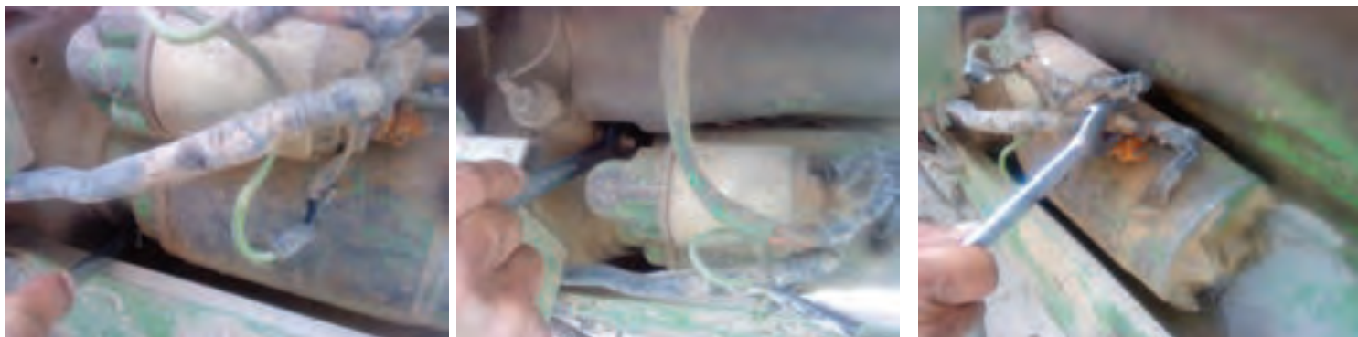
شکل ۵۰-۶ باز کردن کابل مثبت از استارت
