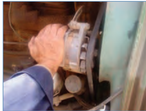
شکل ۳۰-۳ فشار دادن مولد به سمت موتور
