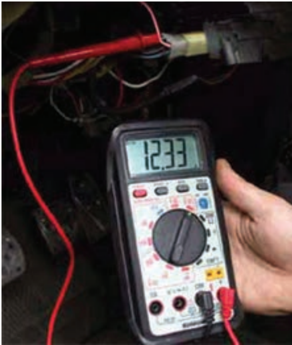
شکل ۲۸-۱۱- اندازه‌گیری ولتاژ در ترمینال ورودی سوئیچ
