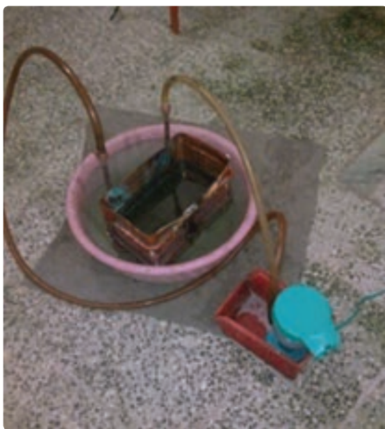
شکل ۱۹-۵- رسوب‌زدایی با پمپ
