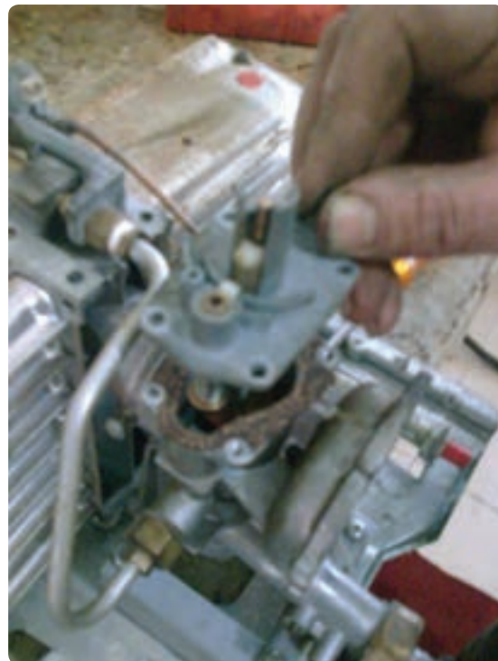
شکل ۱-۲۰- رگولاتور گاز بر روی آب گرم کن
