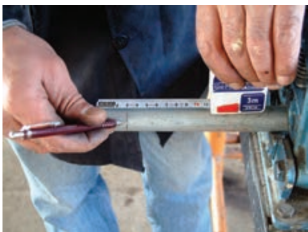
شکل ۱-۵۳- مشخص کردن محل برش
