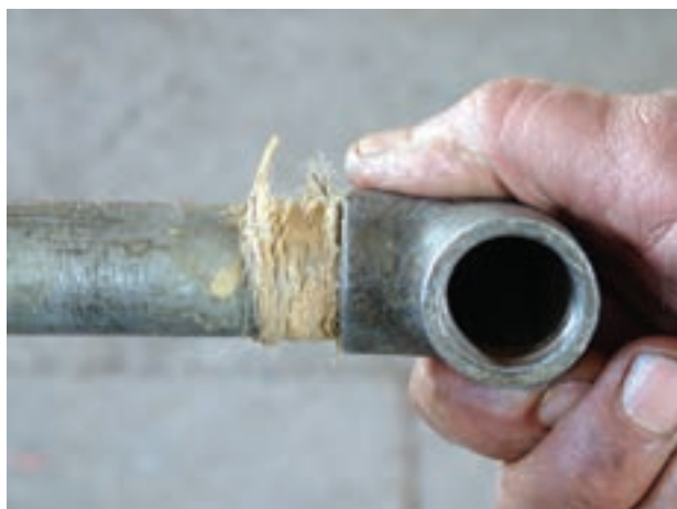
شکل ۵-۹۱- بستن فیتینگ بر روی سردنده
