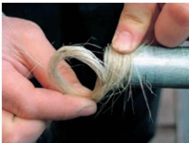
شکل ۵-۱۳۸- پیچیدن مواد آب‌بندی به سردنده‌ها
