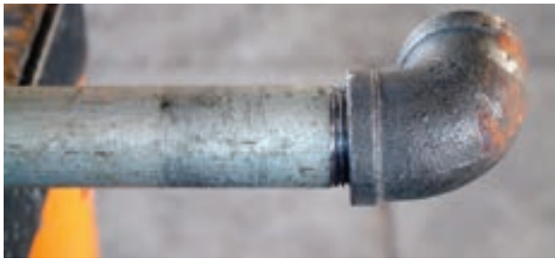
شکل ۵-۹۹- سفت کردن مناسب فیتینگ به لوله
