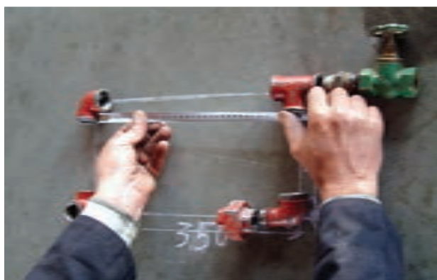
شکل ۱۴۹-۵ اندازه گیری طول لوله ها
