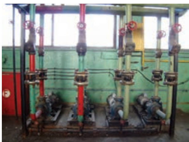
شکل ۳۱-۵- استفاده از اتصال فلنجی برای نصب پمپ‌های زمینی در تهویه مطبوع
