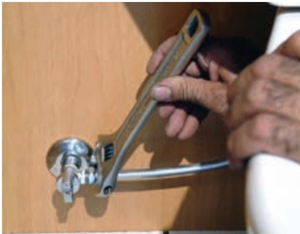
شکل ۳-۲۵۶- سفت کردن مهره‌ی شیر پیسوار
