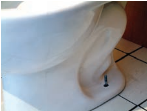
شکل ۲۴۸-۳- قرار دادن توالت فرنگی در محل خود
