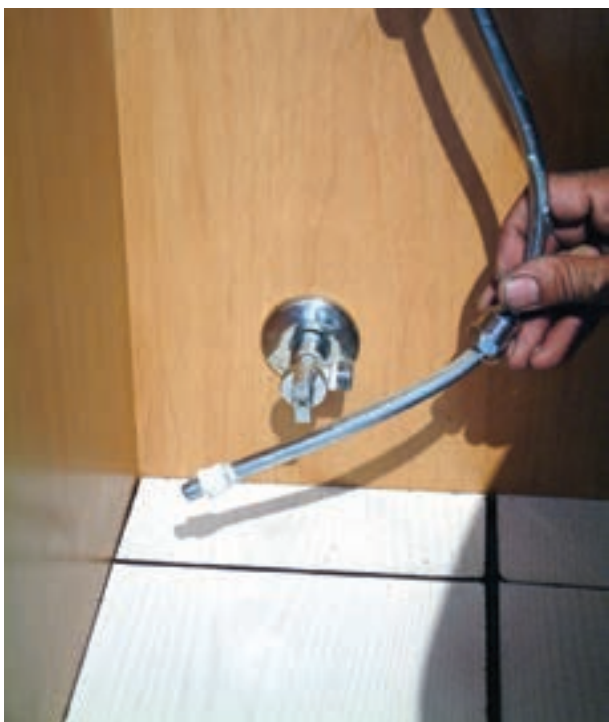
شکل ۲۵۵-۳- خمکاری لوله‌ی پیسوار
