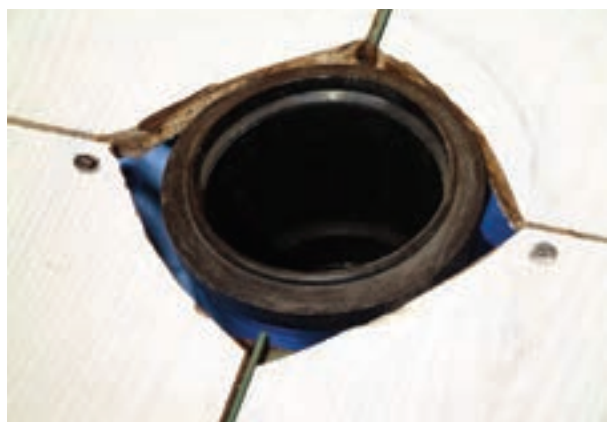
شکل ۲۴۴-۳- قراردادن بوگیر در داخل زانویی
