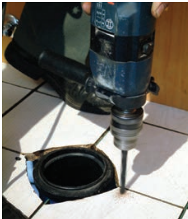
شکل ۲۴۶-۳- سوراخ‌کاری محل‌های علامت‌گذاری شده
