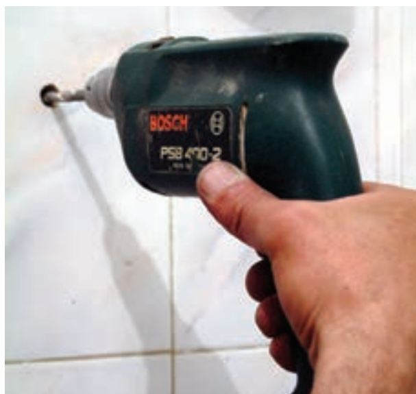
شکل ۳-۴۱ سوراخ کاری محل نصب پیچ‌ها
