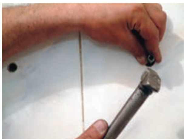
شکل ۳-۴۲ کوبیدن رولپلاک‌ها در درون سوراخ‌ها
