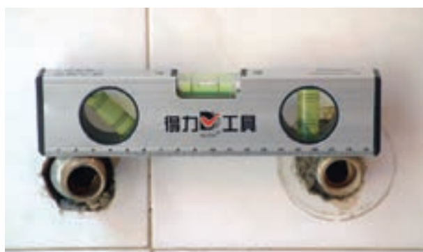
شکل ۲-۲۰۳- کنترل تراز بودن دنباله ها
