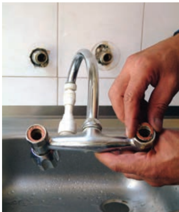
شکل ۱۷۱-۲- قراردادن واشر درون مهره‌ی تنه شیرمخلوط
