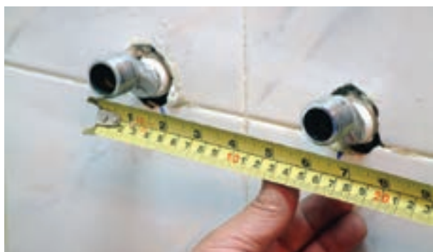
شکل ۲-۱۶۸- کنترل اندازه‌ی محور تا محور دنباله‌ها
