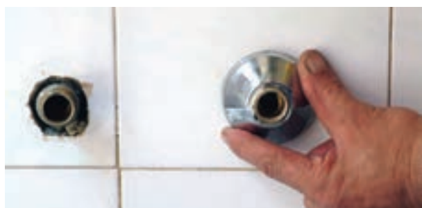
شکل ۲-۱۸۷- اتصال کاسه‌ها به دنباله‌ها
