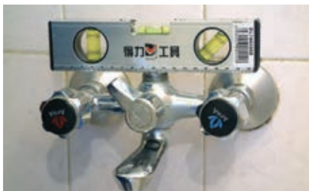
شکل ۲-۲۰۷- سنجش تراز بودن شیر مخلوط دوش
