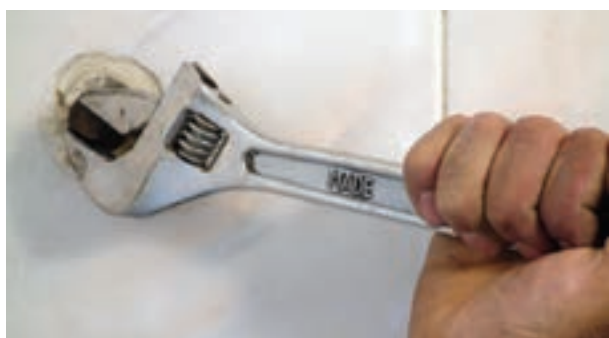
شکل ۱۹۸-۲- باز کردن درپوش‌ها
