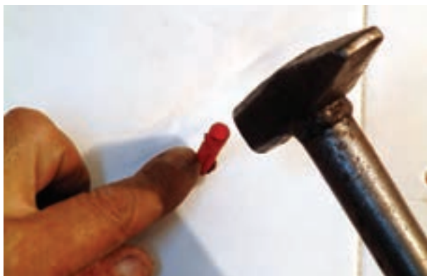
شکل ۱۹۳-۲- کوبیدن رولپلاک درون سوراخ
