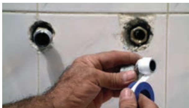
شکل ۱۸۳-۲- پیچیدن نوار تفلون به دنباله‌ها
