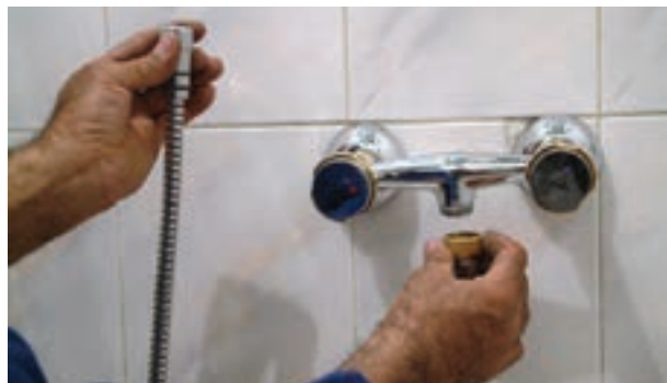
شکل ۲-۱۹۱- اتصال شیلنگ آفتابه به شیر مخلوط توالت
