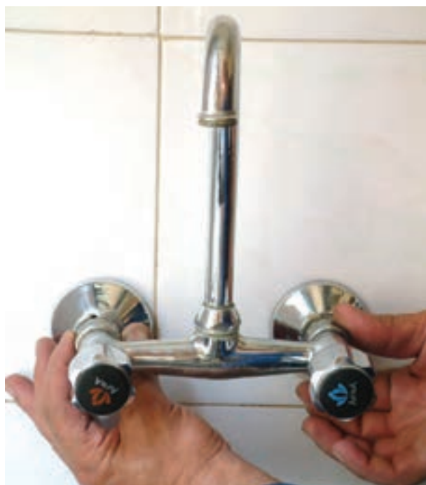
شکل ۱۷۲-۲ پیچیدن مهره‌ها به دنباله‌های شیر مخلوط
