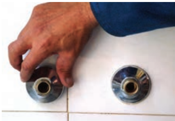
شکل ۱۷۰-۲- بستن کاسه‌ها به دنباله‌ها با دست
