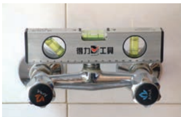
شکل ۱۷۴-۲ سنجش تراز بودن شیر مخلوط دیواری
