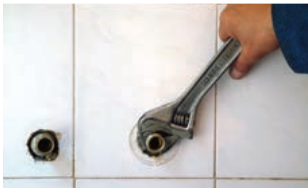
شکل ۲-۲۰۱- سفت کردن دنباله ها با آچار
