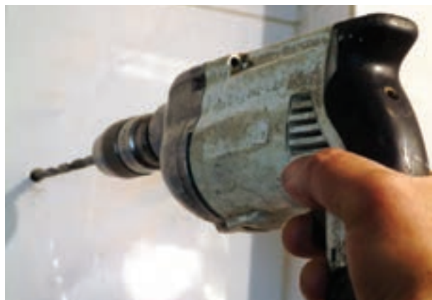
شکل ۲-۱۹۲- سوراخ کردن محل نصب بست آویز
