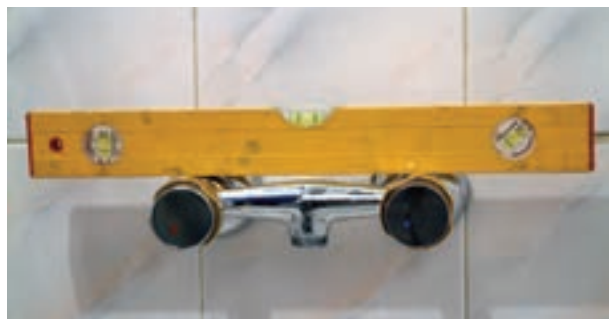
شکل ۲-۱۹۰- سنجش تراز بودن شیر مخلوط
