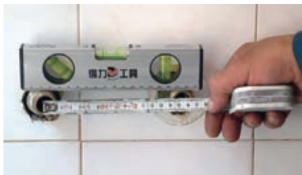
شکل ۲-۱۸۶- کنترل صاف بودن و اندازه‌ی دنباله‌ها
