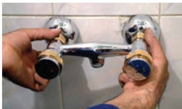
شکل ۲-۱۸۸- اتصال شیر مخلوط توالت به دنباله‌ها
