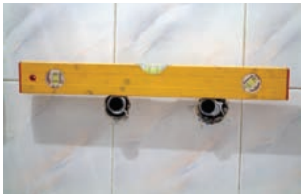
شکل ۱۶۹-۲- کنترل صاف بودن دنباله‌ها
