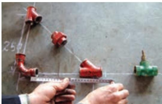
شکل ۱۳۴-۵— اندازه‌گیری لوله‌های مورد نیاز
