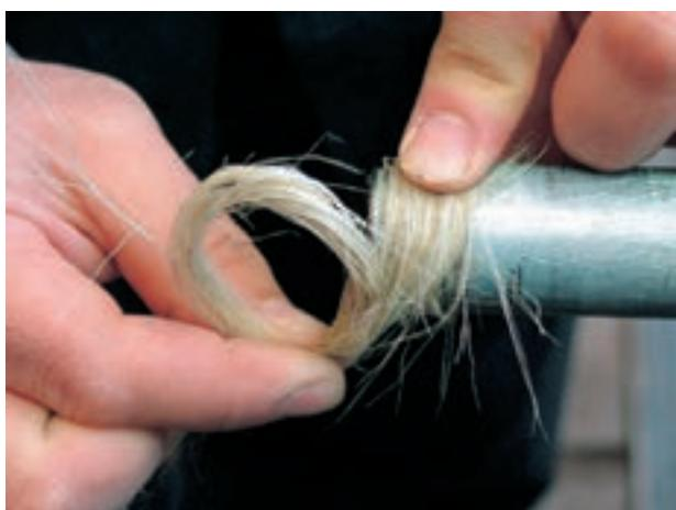
شکل ۱۳۸-۵- پیچیدن مواد آب‌بندی به سردنه‌ها
