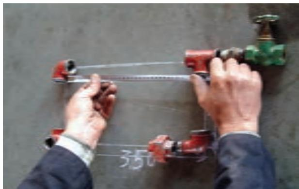
شکل ۱۴۹-۵-۱۴۹— اندازه‌گیری طول لوله‌ها
