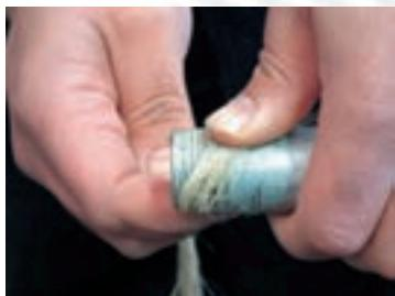
۱۶- آیا روش پیچیدن کنف بر روی سردنه، در شکل رویه‌رو، صحیح است؟
