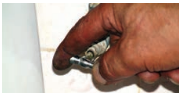
شکل ۱۴۶-۲- عمل هواگیری
