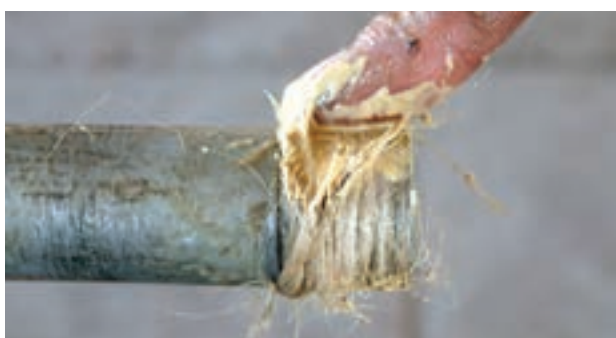
شکل ۵-۵۷- مالیدن خمیر آب بندی بر روی کنف
