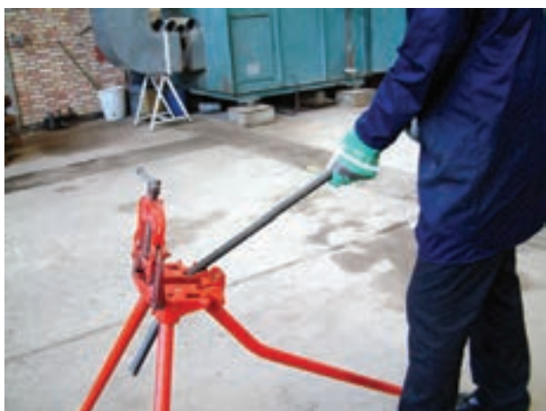
شکل ۳-۹- خم‌کاری لوله به وسیله‌ی گیره‌ی صحرایی
