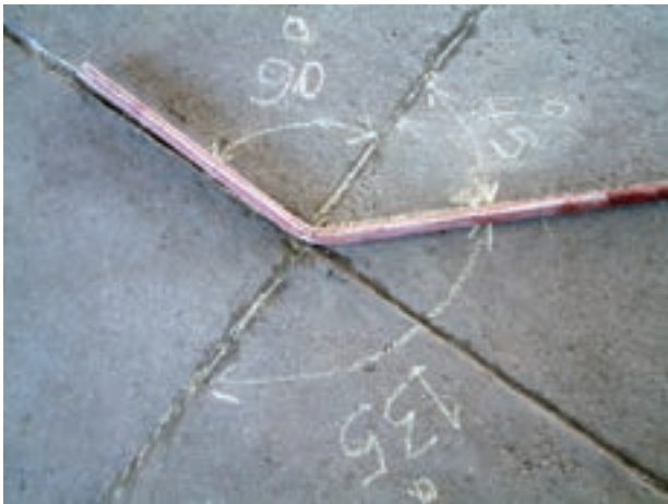
شکل ۳-۲۹- کنترل خم لوله‌های ۴۵ درجه
