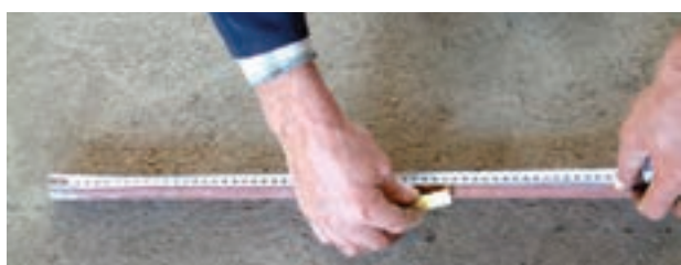
شکل ۳-۵۴ خط کشی لوله و تعیین محل‌های خم
