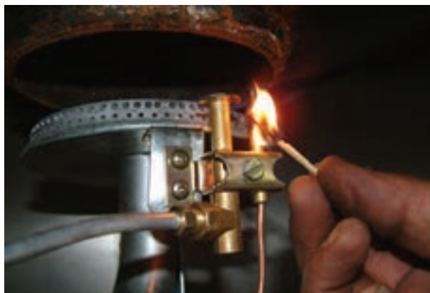
شکل ۱-۱۰۵ مشتعل کردن شمعک به وسیله‌ی شعله‌ی کبریت
