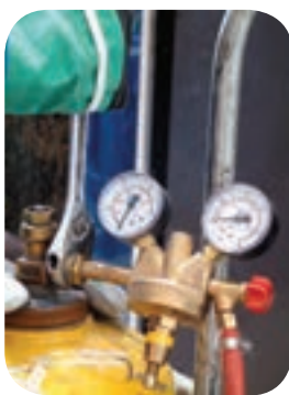
محکم کردن اتصالات رگولاتور به کپسول گاز
