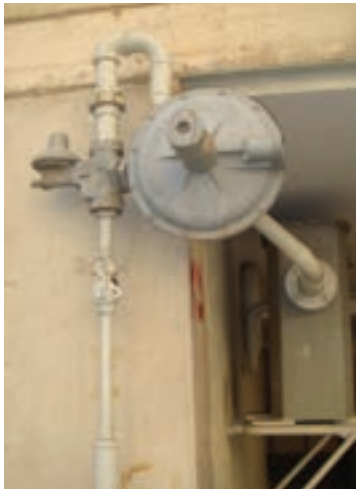
▲ شکل ۲-۹۳: علمک و رگولاتور روی آن
