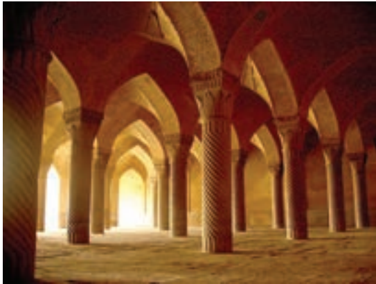
▲ شکل ۴-۶۹ قوس‌های آجری (مسجد وکیل شیراز)
