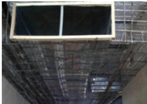
▲ شکل ۱-۵۸- سقف کاذب از نوع رابیتس با اندود گچی و رابیتس کاری زیر سقف کاذب
