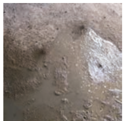
شکل ۱- ۱۰۳: خیس کردن سطح زیر کار
