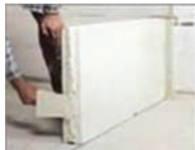
شکل ۱ - ۳۶: طریقه نصب بلوک های گچی
