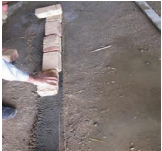
شکل ۱ - ۹۱ : نحوه چیدن آجر در امتداد ریسمان کار
