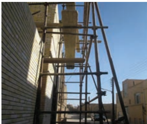
شکل ۱-۱: داربست فلزی برای چیدن دیوار
