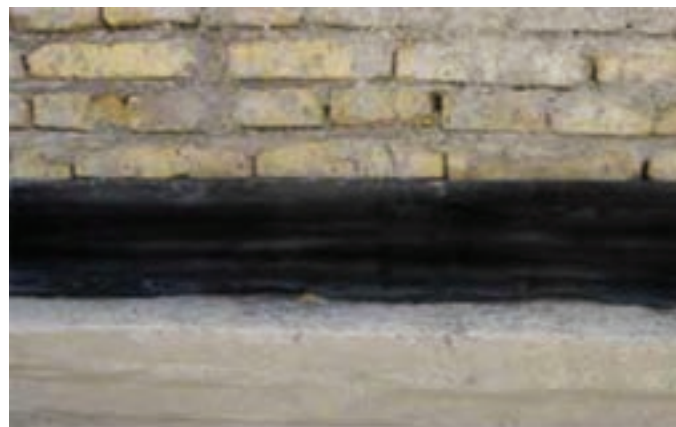
شکل ۱- ۳۰ : دیوار روی کرسی چینی
