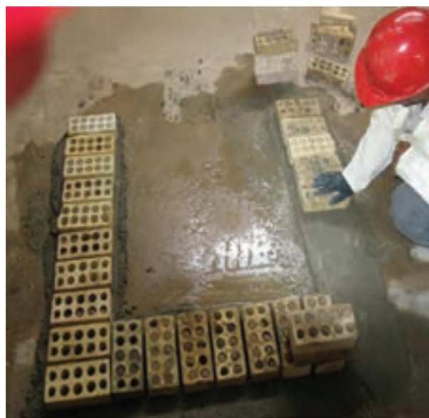
شکل ۱ - ۳۳ (ج): ریسمان کشی و چیدن ضلع سوم
