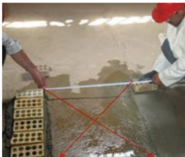
شکل ۱ - ۳۳ (ب): جدا کردن اندازه دو طرف دیگر
