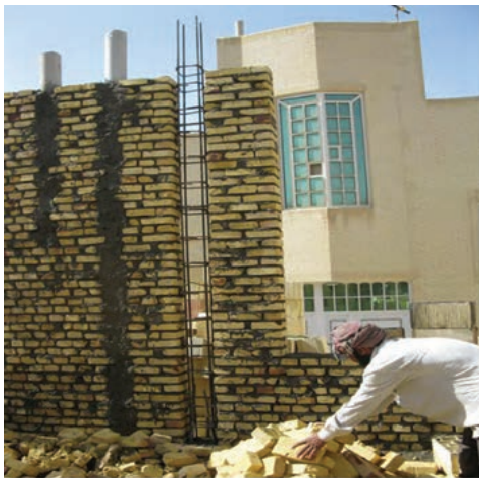
شکل ۱ - ۶۰: اتصال کلاف قائم و افقی در دیوار
