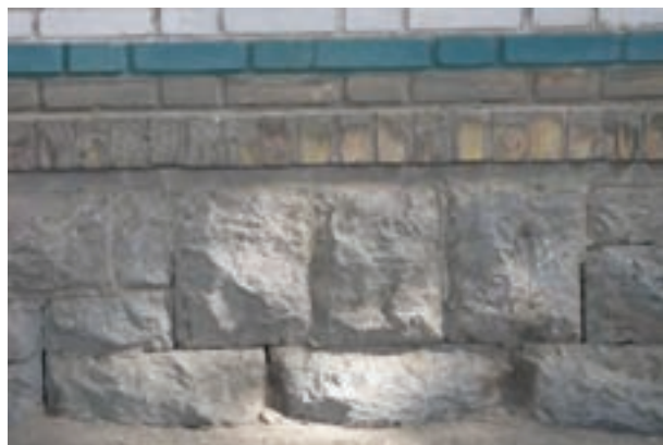
شکل ۱ - ۱۵ : کاربرد سنگ در پایه های ساختمان
