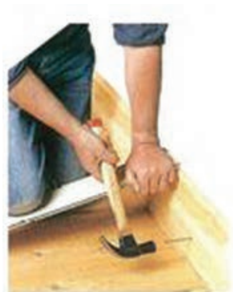
شکل ۳- ۲۹: نصب قرنیز چوبی با میخ
