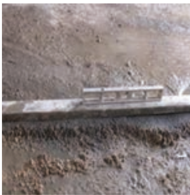
شکل ۱- ۱۰۵: تراز کردن روی ملات
