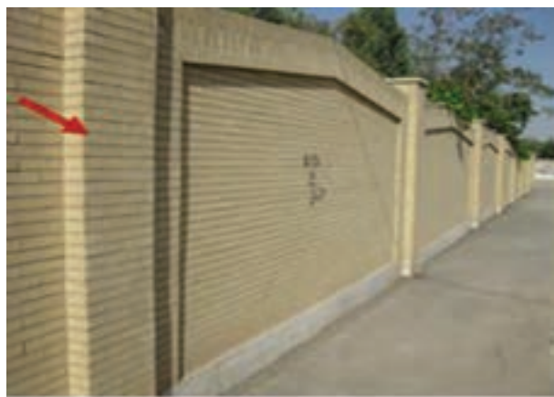
شکل ۱ - ۵۸: وابند در دیوار حصارکشی
