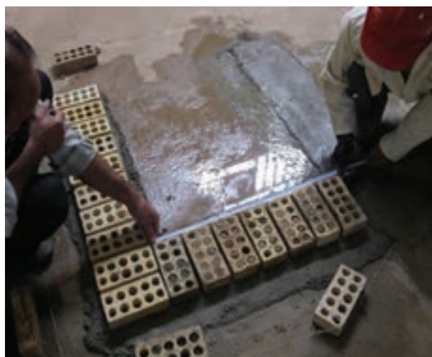
شکل ۱ - ۳۳ (الف): برداشتن طول دیوار
