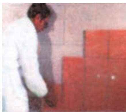
شکل ۱ - ۴۳: نصب کاشی روی قطعات پیش ساخته گچی
