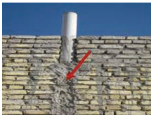
شکل ۱- ۶۵: پر کردن درز لوله‌ها
