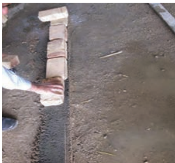
شکل ۱- ۷۴: نحوه چیدن آجر در امتداد ریسمان کار
