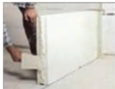
شکل ۱ - ۳۶: طریقه نصب بلوک های گچی
