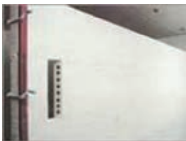
شکل ۱ - ۳۷: دیوار جداکننده با قطعات پیش ساخته گچی
