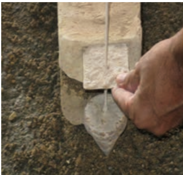
شکل ۱ - ۹۴ : شاقول کردن نبش کار
