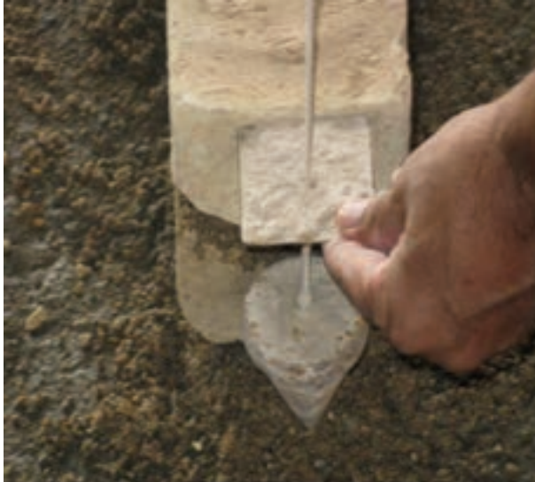
شکل ۱- ۷۷: شاقول کردن نبش کار
