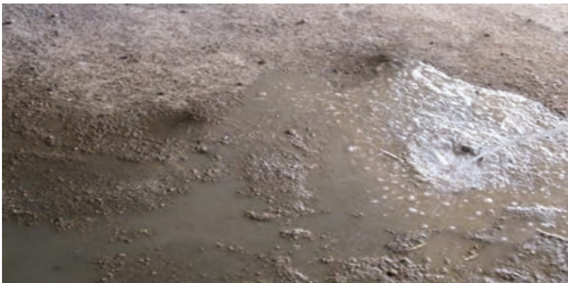
شکل ۱ - ۶۷: خیس کردن سطح زیر کار
