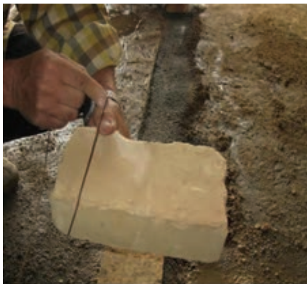
شکل ۱- ۷۲: نحوه بستن ریسمان کار به آجر
