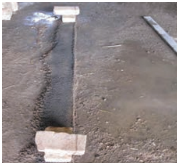
شکل ۱- ۷۳: بادخور نمودن ریسمان کار
