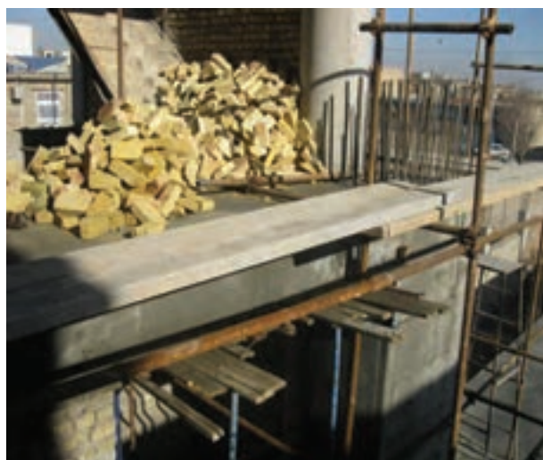
شکل ۱-۲: ضخامت مناسب برای تخته زیر پایی
