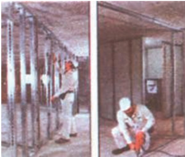
شکل ۱-۴۴: قاب سازی جهت اتصال روکش های گچی
