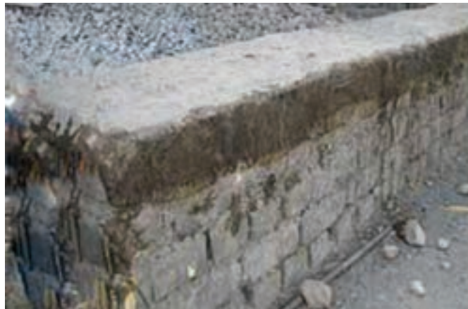
شکل ۱- ۲۹ : کرسی چینی یا عایق کاری رطوبتی
