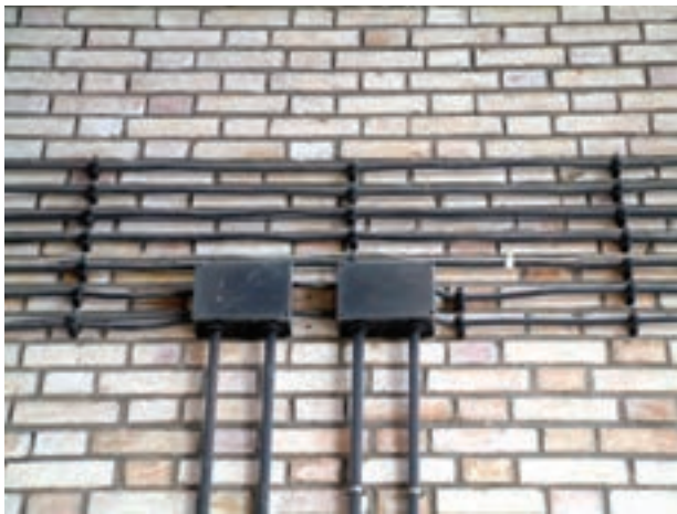
شکل ۵-۵۷- کابل‌کشی روی دیوار
