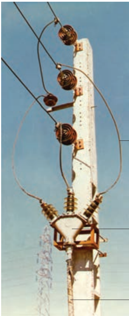
شکل ۳-۶ - اتصال سر کابل روغنی بیرونی به شبکه‌ی هوایی
