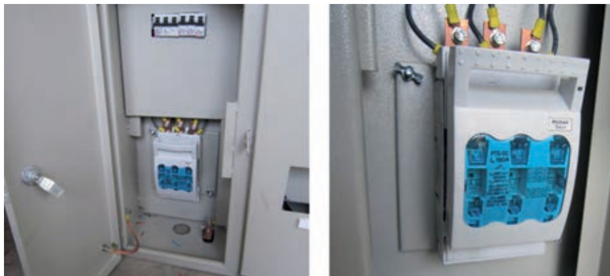
شکل ۲۳-۳- محل ورود کابل اصلی به داخل تابلو
