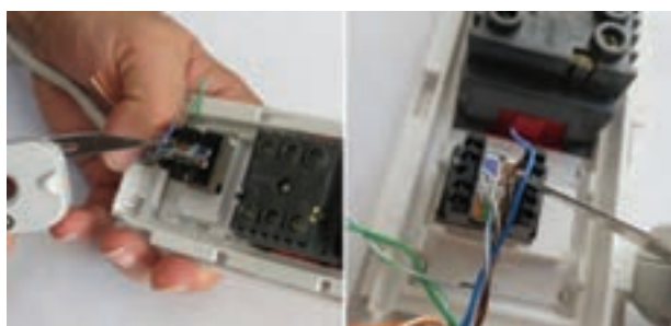
شکل ۶- خارج کردن سیم از ترمینال شبکه
