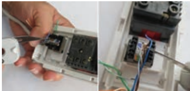
شکل ۶- خارج کردن سیم از ترمینال شبکه
