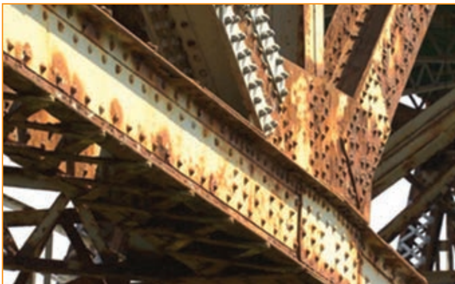
شکل ۱۳- پل‌های آهنی در مجاور رطوبت و اکسیژن هوا به آهستگی خورده می‌شوند.
