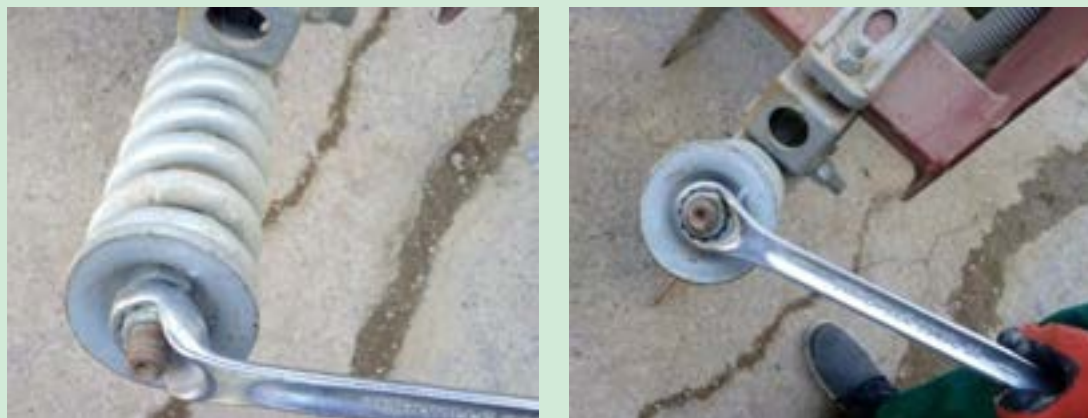
شکل ۴۵- آچارکشی نقاط اتصال اجزا و قطعات
