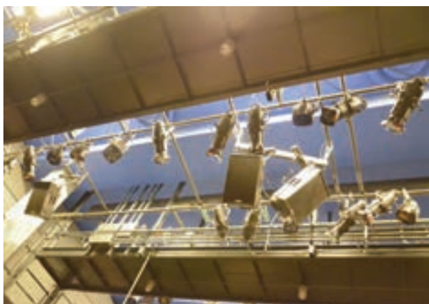
شبکه لوله‌ای (پایپ گرید) به همراه نورهای نصب شده
