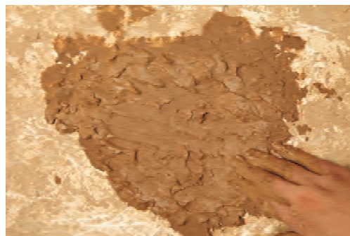
شکل ۱۱- تهیه گل یکنواخت با دوغاب
