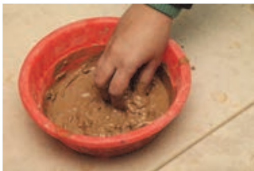
شکل ۱۱- تهیه گل یکنواخت با دوغاب
