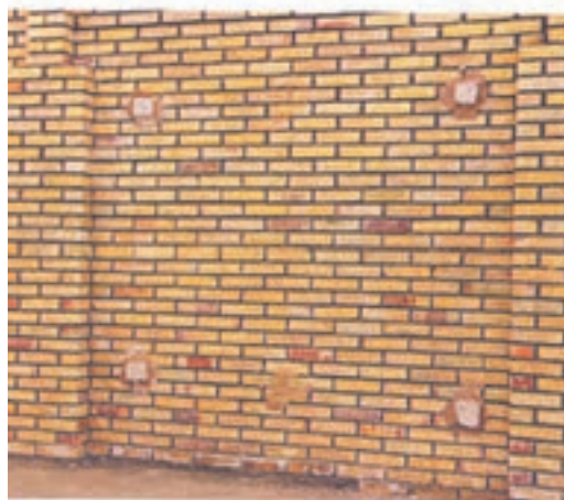
▲ شکل ۲۱-۳ کرم‌بندی ابتدا و انتهای دیوار
