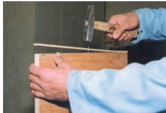
تصویر ۱۲-۶-۲ زهوارکوبی دور لبهٔ زیرساخت
