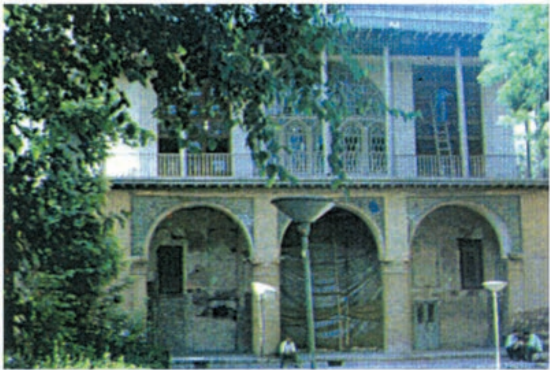
شکل ۱۲۱- عمارت چهلستون قزوین
