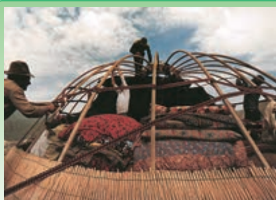
۳-۲-۶- بررسی مصالح، تکنولوژی و سازه‌ی ساختمان:
