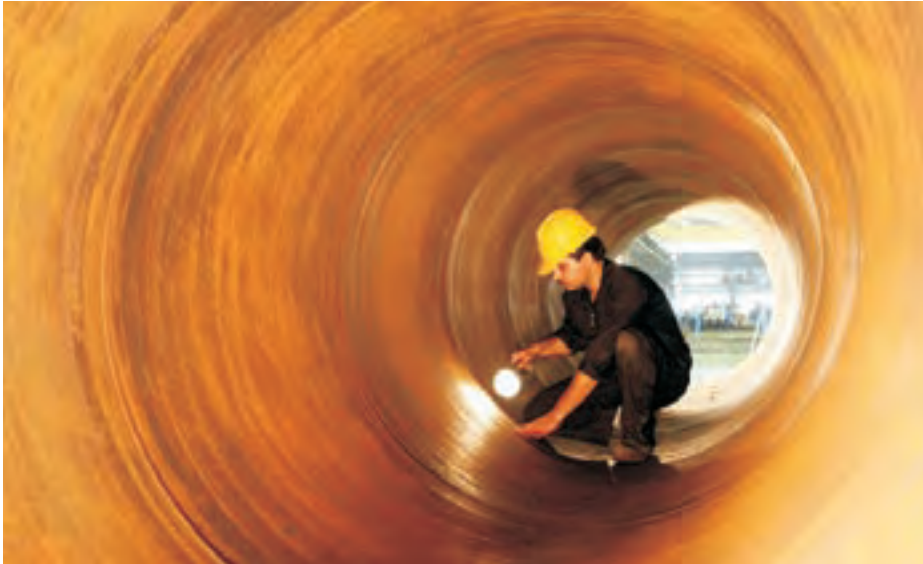
شکل ۴-۲۹ بازرسی چشمی لوله‌ها
