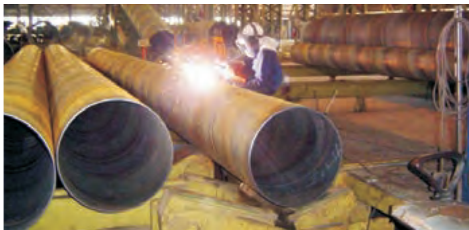
شکل ۴-۳۱ تعمیر لوله‌های معیوب
