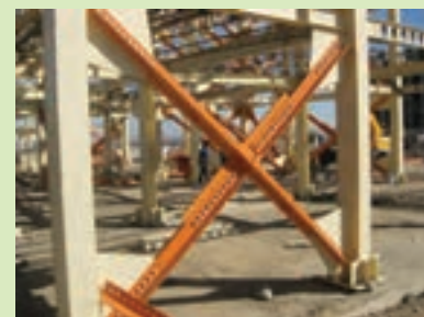
اجرای اتصال بادبندها از نوع پیچی
