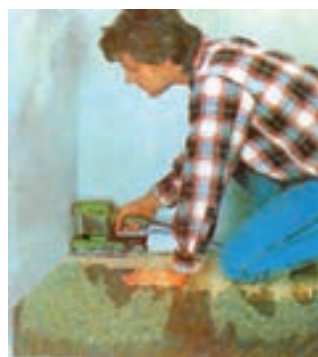
شکل ۱۲-۲۲ تمیز کردن گوشه کار با سنبلاده خشن
