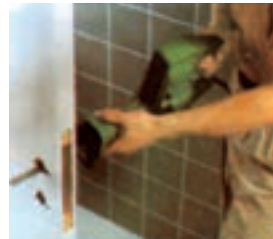
شکل ۲-۱۳- برش جای قفل با ارّه افقی چکشی
