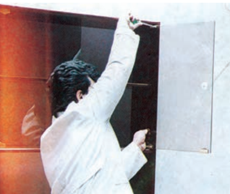
شکل ۱۰-۱۳- نحوه نصب درهای شیشه‌ای کتابخانه
