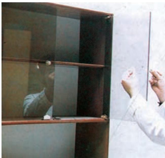
شکل ۱۲-۱۳- نحوه نصب دستگیره در شیشه‌ای
