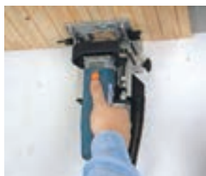
شکل ۹-۱۱۵- نحوه ایجاد شیار در لمبه کوبی سقف با دستگاه بیسکویتی
