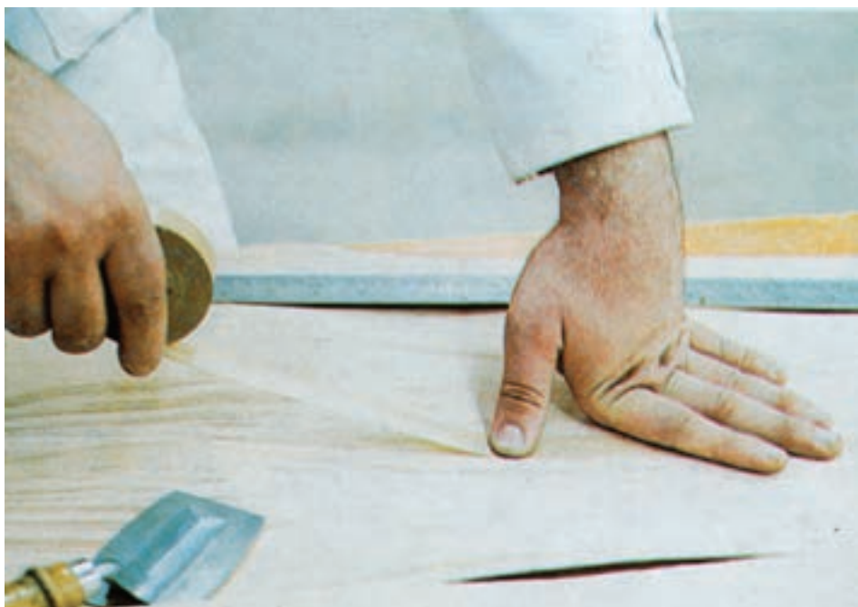
شکل ۹-۵- نحوه‌ی چسباندن نوار چسب کاغذی روی درز طولی روکش‌ها
