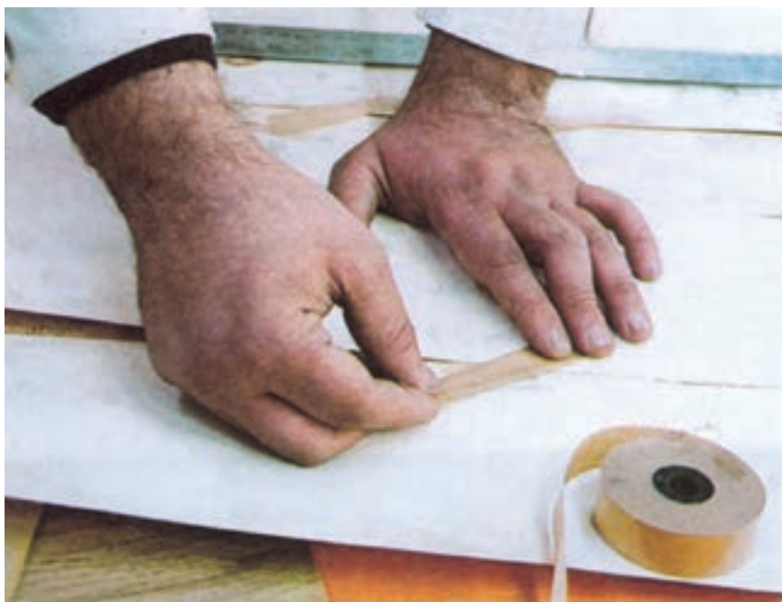
شکل ۱۰-۵- نحوه‌ی چسباندن تکه‌های نوار چسب کاغذی روی درز روکش‌ها
