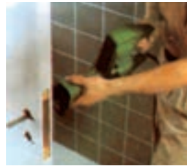
شکل ۲-۱۳- برش جای قفل با اره افقی چکشی
