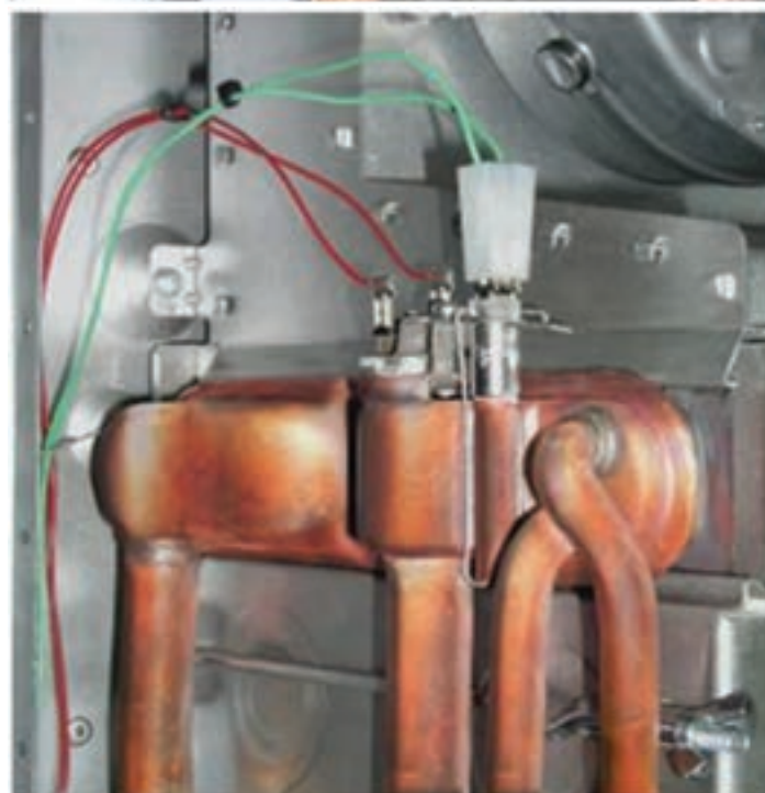
شکل ۱۶-۱۴- موقعیت سنسور دمای آب رفت به رادیاتور
