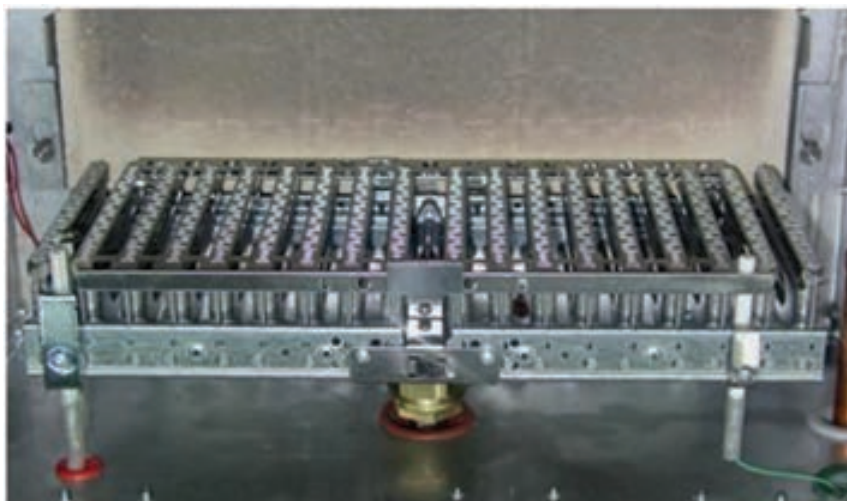
شکل ۱۲-۱۴- الکتروود یون در مشعل
