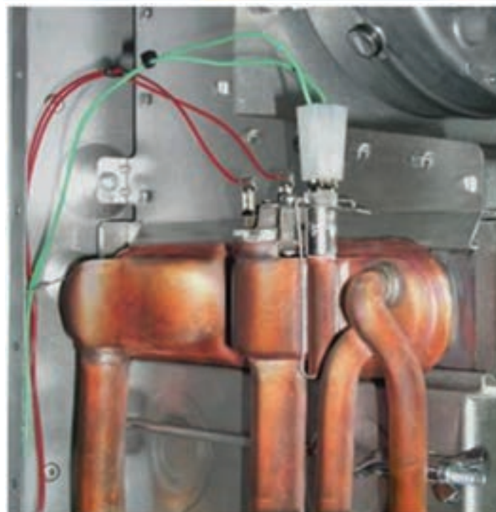
شکل ۱۶-۱۴- موقعیت سنسور دمای آب رفت به رادیاتور
