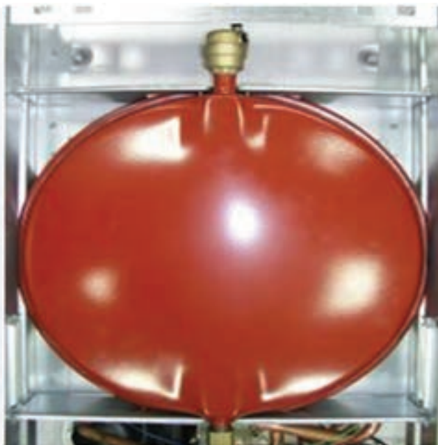
شکل ۲۲-۱۴- شیر هواگیری اتوماتیک
