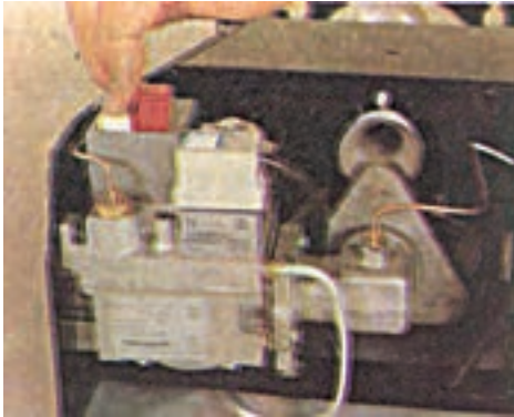
شکل ۷-۴- روشن کردن یک نوع مشعل
