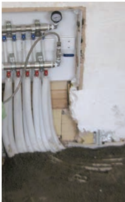
شکل ۳-۲۱- پوشاندن لوله ها
