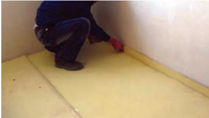
شکل ۱۳-۳- عایق کاری پیرامونی
