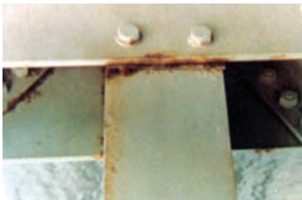
شکل ۶-۴- آسیب دیدگی در قسمت درزهای محل اتصال
