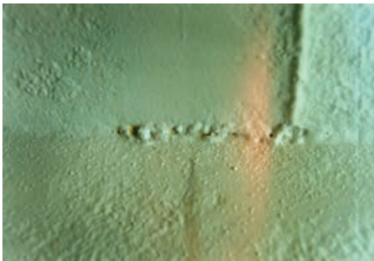
شکل ۶-۳- جوش کاری و آماده سازی نامناسب
