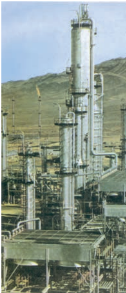
شکل ۲-۴- دستگاه تقطیر اتمسفری
