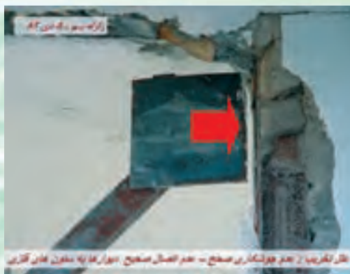
عزل تخریب: عدم جوشکاری صحیح - عدم اتصال صحیح دیوارها به ستون های فلزی
