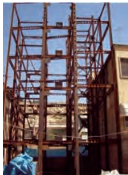
شکل ۴-۱۷ ستون دابل با ورق تقویتی
