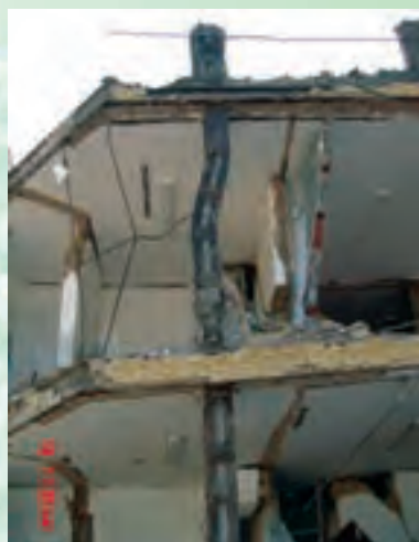
نمونه‌هایی از کمانش کلی ستون
