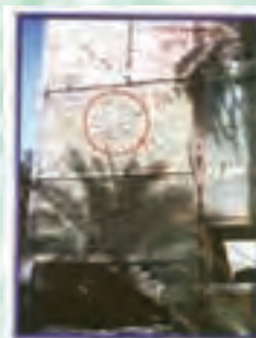
استفاده از مقاطع نامناسب در مهاربند ساختمان
