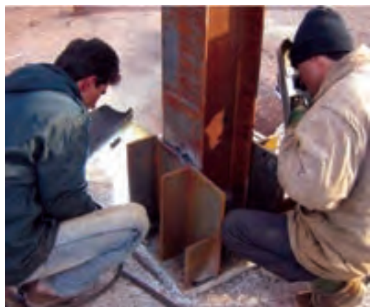
شکل ۴-۲۶- جوشکاری کامل پای ستون و مملقات آن
