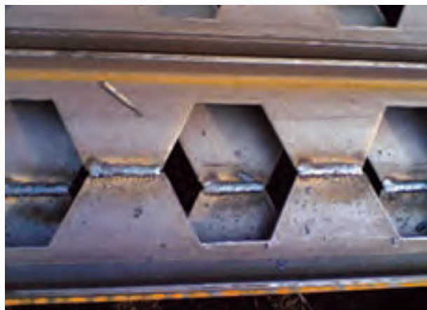
جوشکاری کامل دوطرف تیر لانه‌زنبوری
