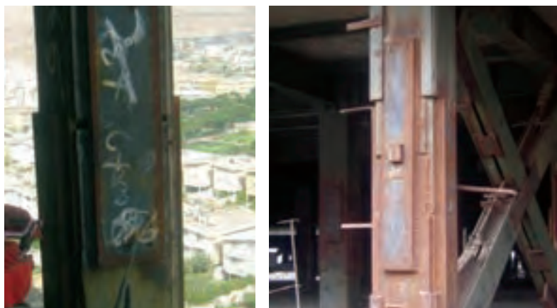
شکل ۸-۲۴- وصله جوشی ستون جعبه‌ای
