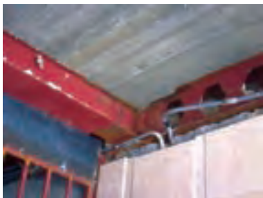
شکل ۵-۲۰- سافت تیرهای لانه زنبوری و نصب آن‌ها
