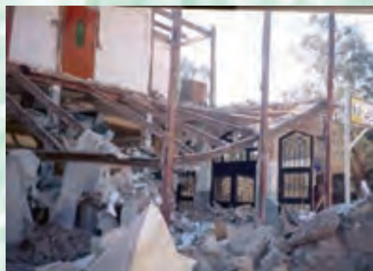
اجرای ناصحیح نبشی نشیمن در تکیه‌گاه تیرو ستون، منجر به تخریب کلی سقف شده است.
