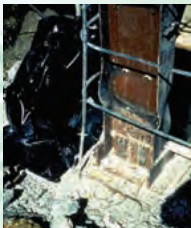
کمانش موضعی بال‌ها و جان ستون در پایین ستون طبقه اول در گوشه‌ی ساختمان
