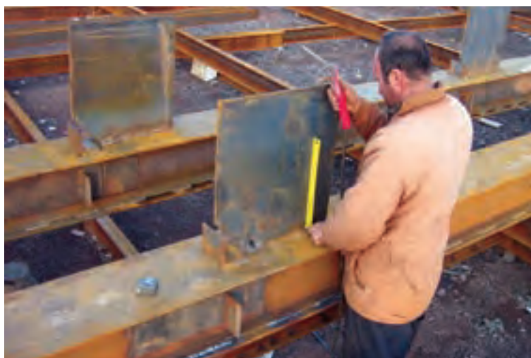
شکل ۴-۲۲- نصب ملمقات ستون روی شاسی‌های مونتاژ
