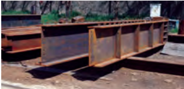
شکل ۵-۱۵- شاهتیرهای ساخته شده از تیرورق
