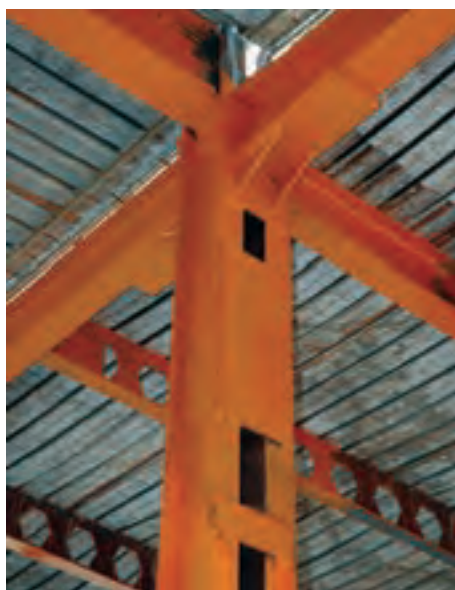
شکل ۴-۲۱- اتصال تیر به ستون دابل پا باز
