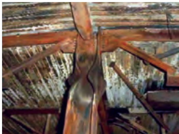
شکل ۴-۵- کمانش موضعی ستون
