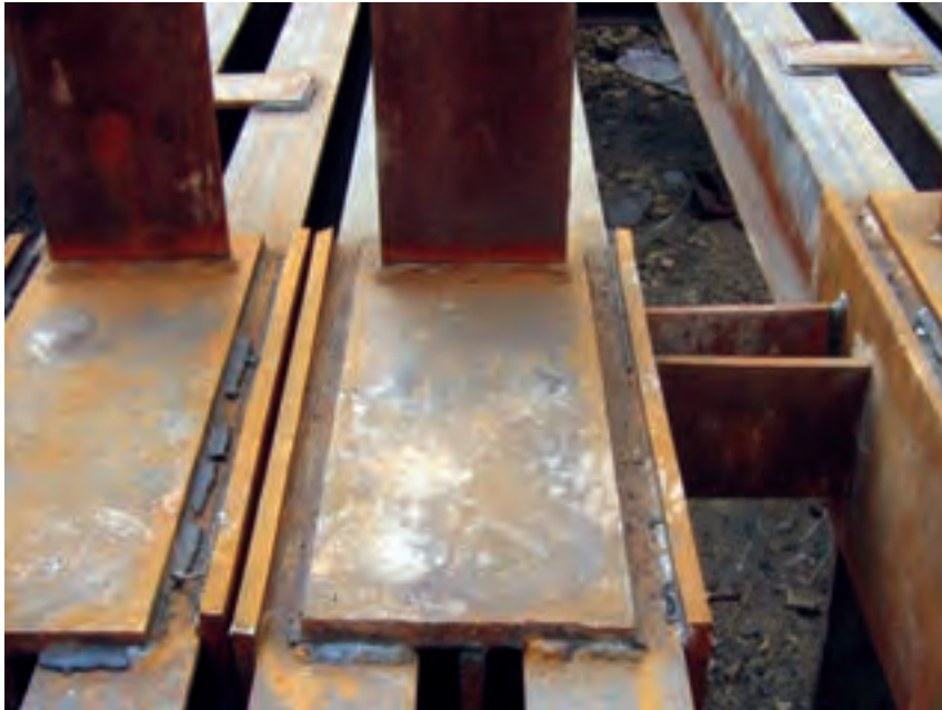
شکل ۴-۲۳- جزئیات ورق اتصال در قاب‌های فمشی
