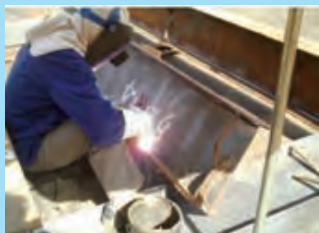
جوش طولی به روش دستی
