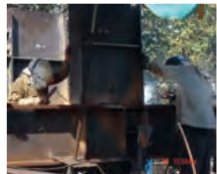
شکل ۱۱-۱۵- فیکسچر مونتاز نهایی قطعات الماکی دستک‌ها روی ستون صلیبی شکل
