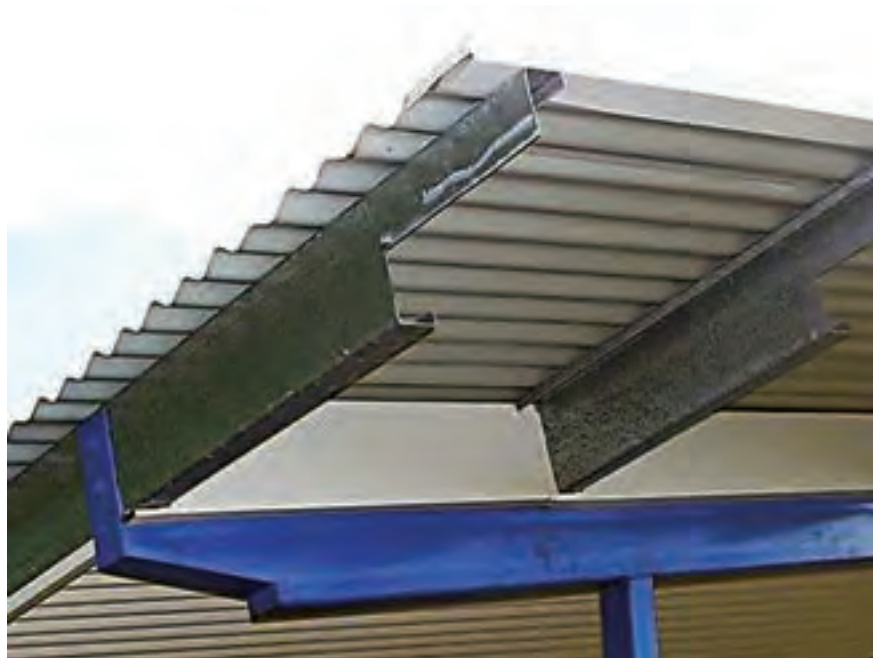
شکل ۵-۱۹- لایه جهت نصب پوشش در ساختمان صنعتی
