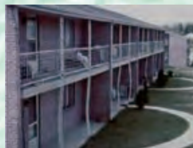
نمونه‌هایی از کمانش کلی ستون
