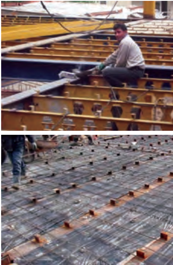
شکل ۵-۲۵- مراحل اجرای سقف کامپوزیت
