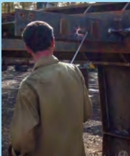
صاف کردن قطعات به کمک مزارت
