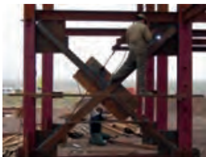
شکل ۸-۱۷- نمونه‌ای اجرای اتصالات مهاربندی
