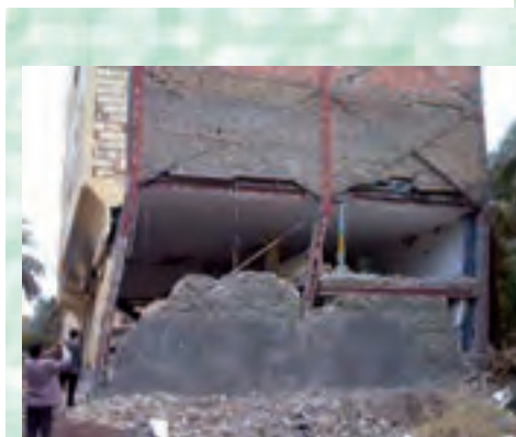
استفاده از مهاربندی ضعیف در یک جهت سازه که منجر به تغییر شکل زیاد سازه شده است
