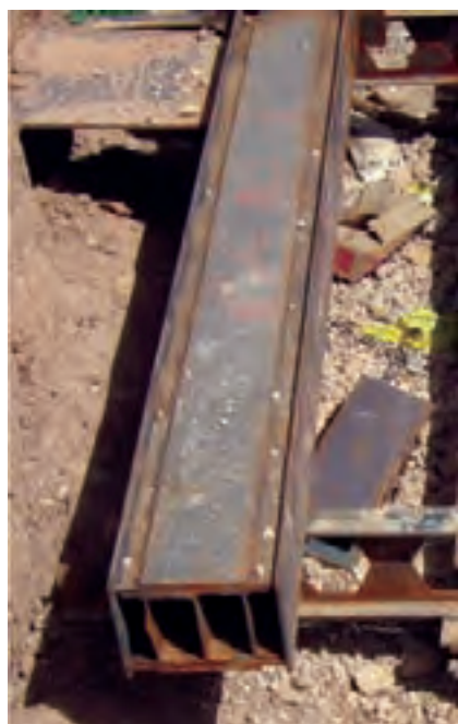
شکل ۴-۱۸- مقطع مرکب سه‌تایی با ورق تقویتی
