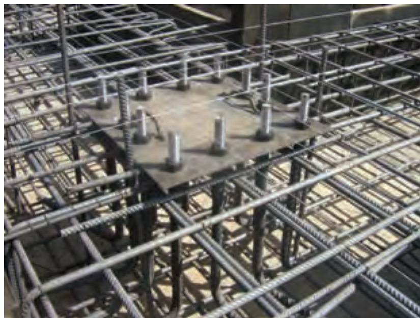
شکل ۳-۱۲- تنظیم پیچ‌های مهاري با شابلن و ریسمان
