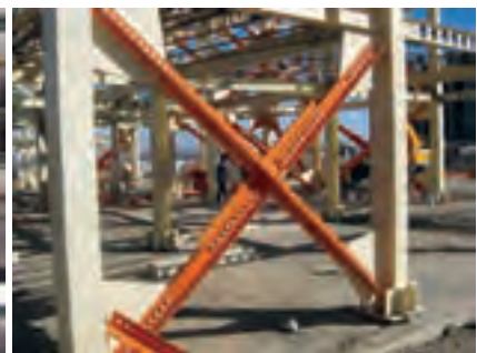
الف- مهاربندهای همگرا در اسکلت فولادی
