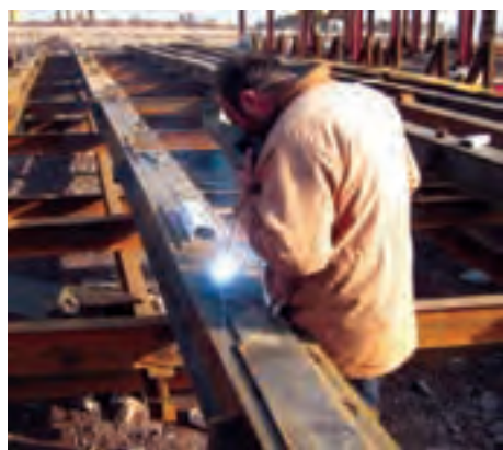
شکل ۴-۱۵- جوشکاری ستون جفت (وی شاسی کار)
