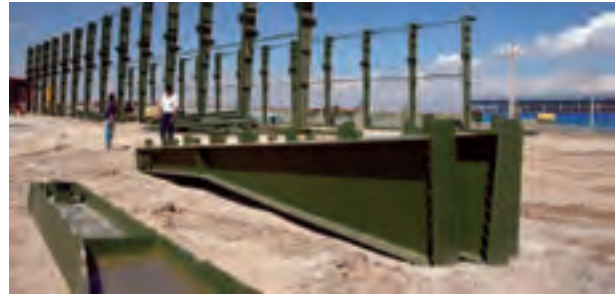
شکل ۵-۱۵- شاهتیرهای ساخته شده از تیرورق
