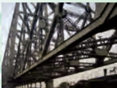
کاربرد المان خربایی در سازه پل فولادی
