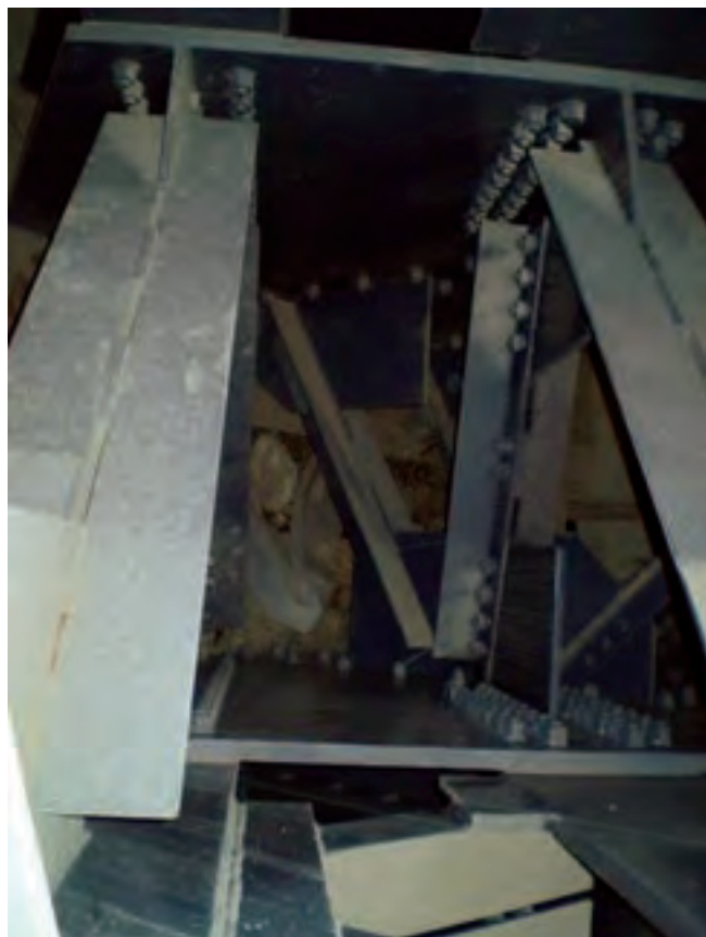
شکل ۱۰-۶ - اتصال پیچ و مهره‌ای اعضای خرپاها
