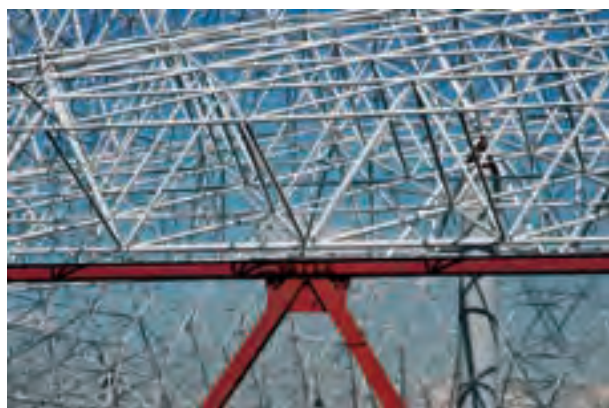
شکل ۱۰-۲۰- نمونه‌ی اتصال اعضای فرپای فضاکار
