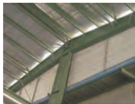
شکل ۱۰-۳۱- اجرای مهاربند افقی در قاب شیب دار
