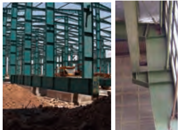
فلنج انتظار در ساختمان صنعتی
