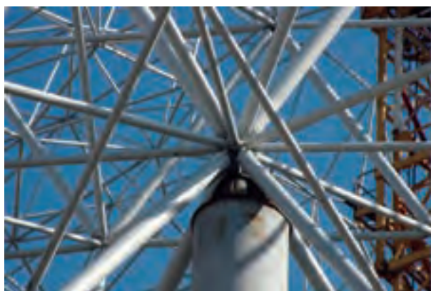
شکل ۱۰-۲۰- نمونه‌ی اتصال اعضای فرپای فضاکار
