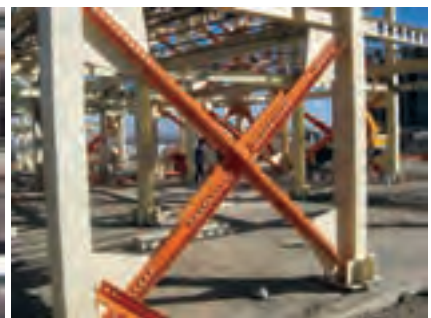
الف- مهاربندهای همگرا در اسکلت فولادی
