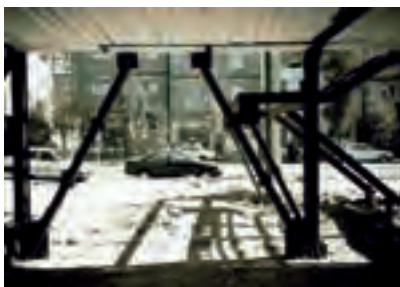
ب- مهاربند دوزنقه واگرا در اسکلت فولادی
