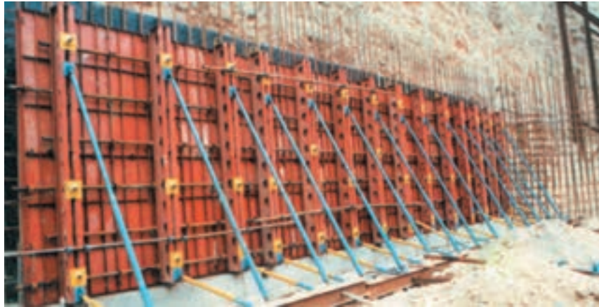
شکل ۲۱-۷- مهار قالب دیوار به وسیله جک های شاغول کننده
