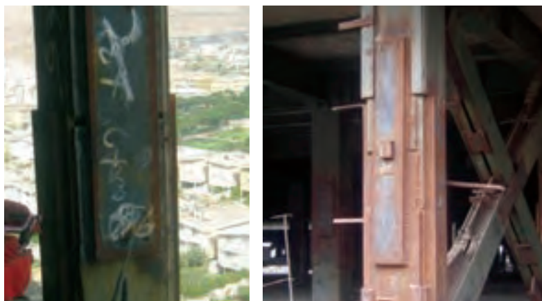
شکل ۸-۲۴- وصله جوشی ستون جعبه‌ای
