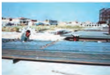
موشکاری نبشی نشیمن (روی زمین)
