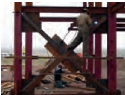
شکل ۸-۱۷- نمونه‌ی امرای اتصالات مهاربندی
