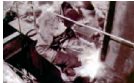
نصب و جوش ورق روسری در محل نصب
