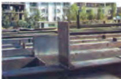
نصب ورق زیرسری روی ستون در کارگاه
