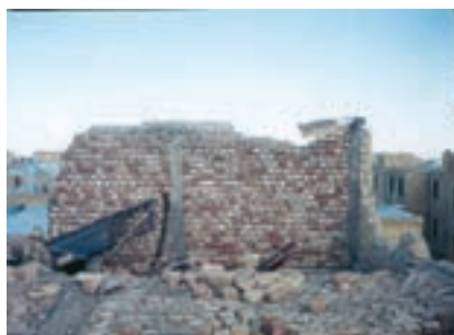
عدم رعایت طول مهاري مناسب در شناژ قائم و عدم اجرای کلاف افقي زیر سقف
