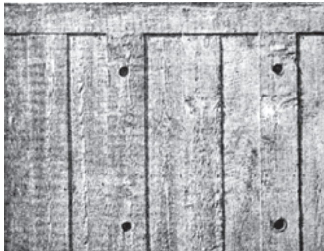
شکل ۶-۳۴- نمونه‌ای از محل‌های مهاری پر نشده
