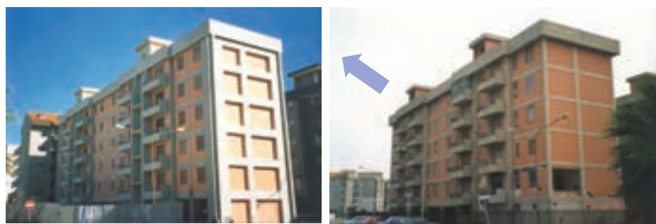
ب - این ساختمان به دلیل ضعف در تیرها و ستون‌های خود، نیازمند مقاوم‌سازی بوده که برای این منظور ابعاد تیرها و ستون‌ها و همچنین میل‌گردهای آن افزایش یافته است.
