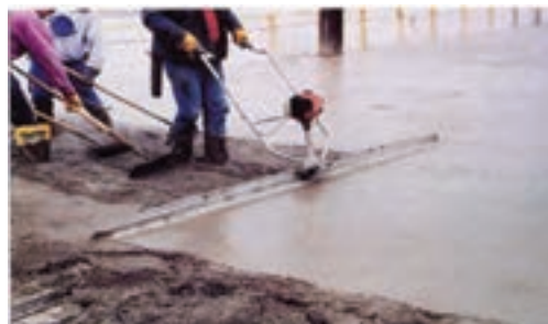
شکل ۶-۲۵- استفاده از شمشه‌های دارای ویبره برای تراز کردن و متراکم نمودن سطح، به صورت همزمان
