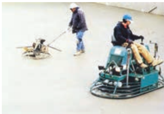
شکل ۶-۲۹- پرداخت نهایی با ابزار مکانیکی
