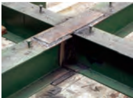
نمونه‌ای از اتصال جوشی در مهاربند سافتمان
