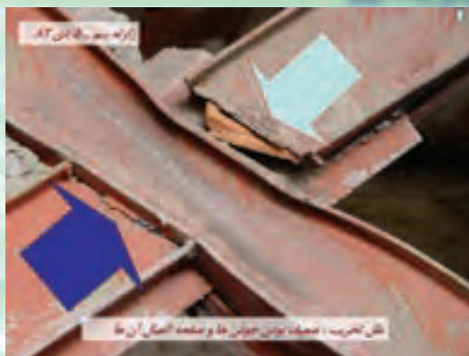
عزل تخریب: ضعف بودن جوش ها و صفحه اتصال آنها
