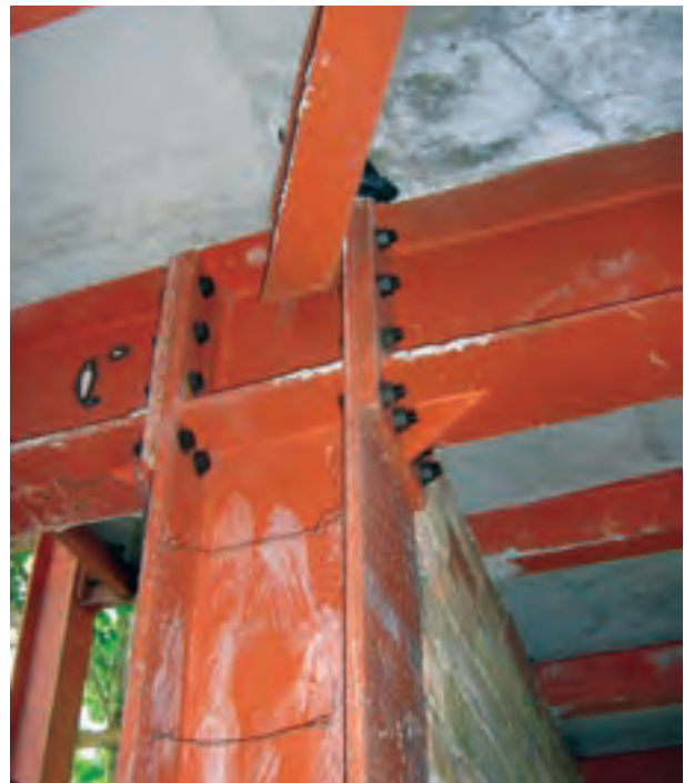
شکل ۷-۸- اتصال پیچی در سافتمان اسکلت فولادی
