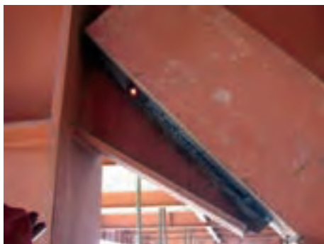
نمونه‌ای از اتصال جوشی در مهاربند سافتمان
