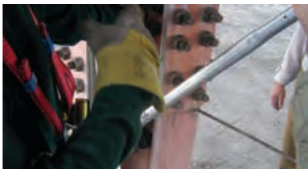
شکل ۷-۳- استفاده از پیچ‌های پرمقاومت در اتصالات
